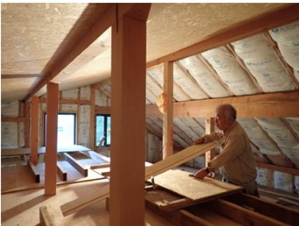
尾方さんがOSB材を加工して、天井にエアータッカー（釘打ち機）で仮止めします。そして、私がビスで固定していきます。天井は斜めで、中途半端な高さなので、常に中腰になり不安定な場所で作業するので腰や脹ら脛が疲労してきます。
